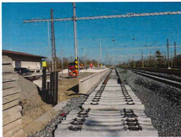
02-32-01 Pokládka podvalov, montáž koľajníc
