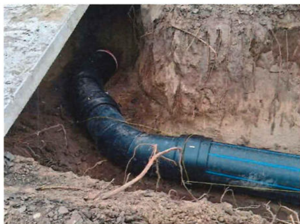
01-37-03.1 Pokládka vodovodu, príprava na prepoj
