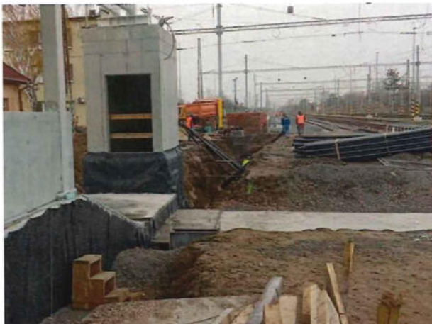
02-34-02 Realizácia kábelovodu
