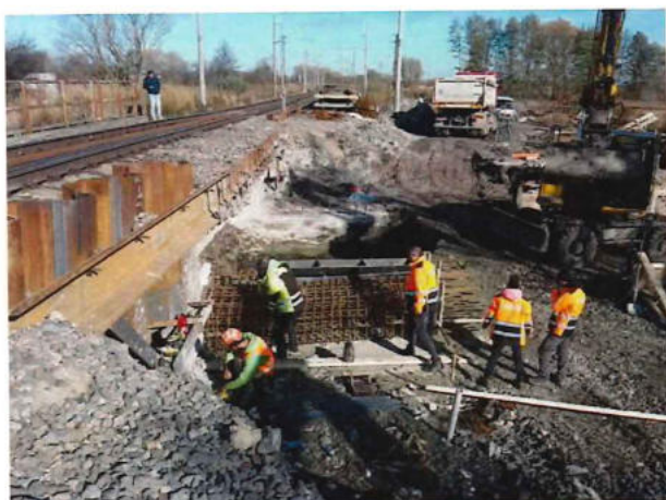
01-33-14 Armovanie a debnenie úložných prahov
