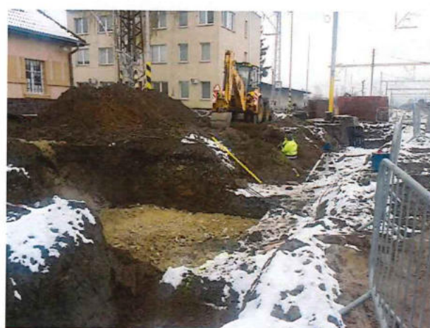
02-34-03 Výkopy, armovanie a debnenie základov
