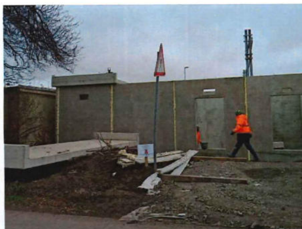
02-34-01 Montáž technologického objektu a montáž strechy
