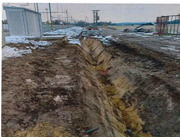
11-32-02 Prehĺbenie nespevnenej priekopy
