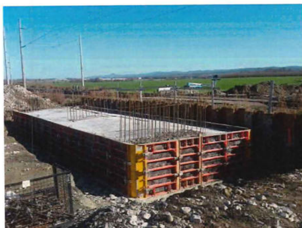
01-33-13 Realizácia základu opory
