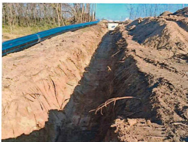
01-37-03.1 Prekládka vodovodu VW
