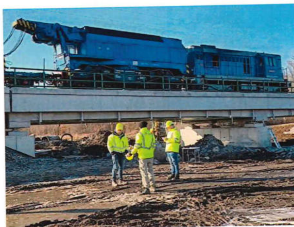
12-33-02 Statická zaťažovacia skúška
