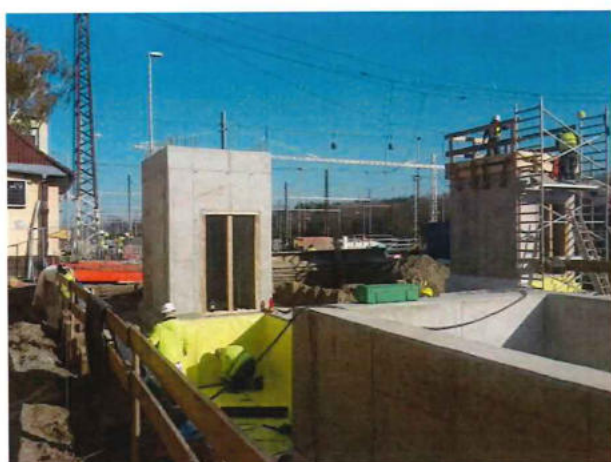
02-33-01 Betonáž stropu šachty, izolácie
