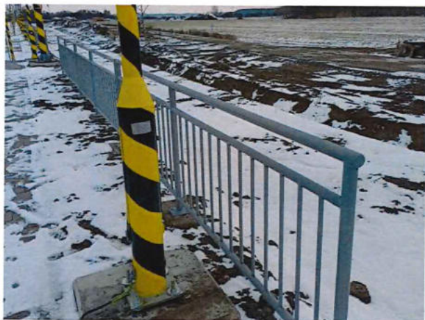
11-32-04 Montáž zábradlia
