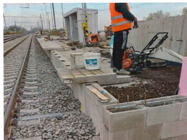
11-32-04 Úprava podkladnej vrstvy
