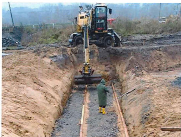
01-33-25 Výkopy a budovanie podkladového lôžka
